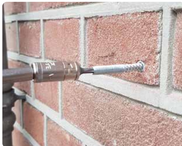
① 1. Draai met een Torx 15 de draadeinden in de plug.
